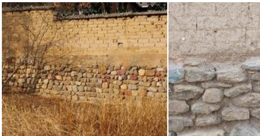
Detalles de la combinación de piedra y adobes de la casa parroquial (izquierda) y muro externo hacia el río (derecha). Fotografías de Rossana Barragán Romano (2024).
